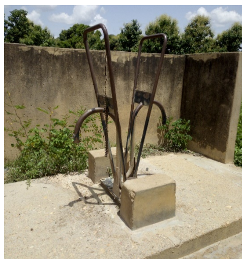
Photo N° 7 : Vergnet (pompage à pieds) Prise de vue : Salifou Bio Afissétou, Août, 2018
