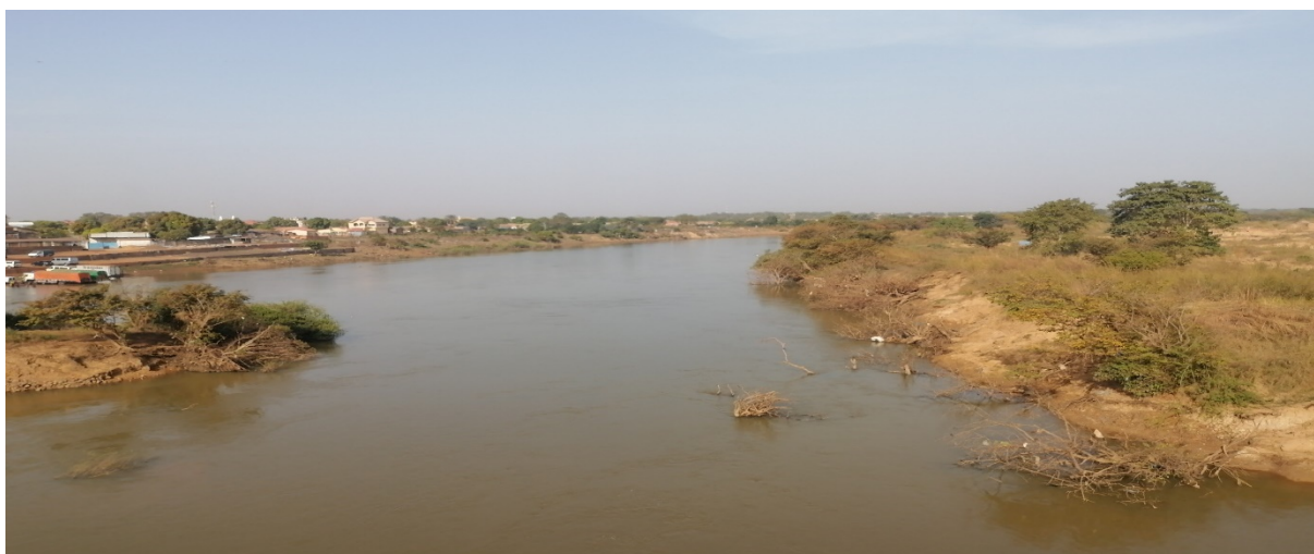
Photo 4 : le long des berges de fleuve Milo dégradés
